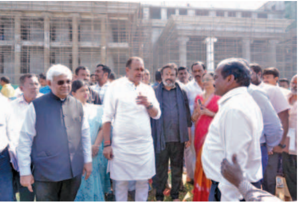
బొల్లారం టీమ్ ను ఆస్పత్రి నిర్మాణ పనులను పర్యవేక్షిస్తున్న మంత్రి కోమటిరెడ్డి వెంకటరెడ్డి, కంబోన్మెంటి ఎమ్మెల్యే శ్రీగణేష్ తదితరులు
